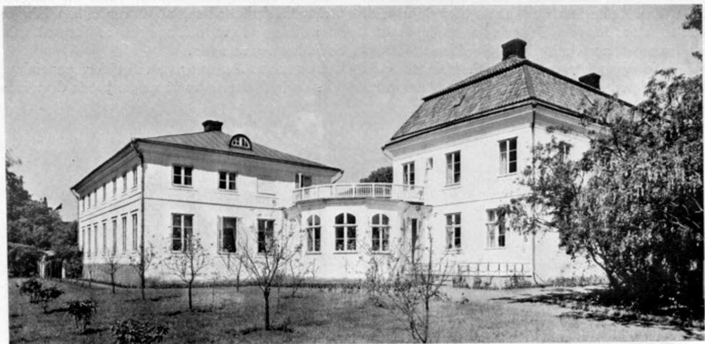
Hufvudbyggnaden och södra flygeln.
