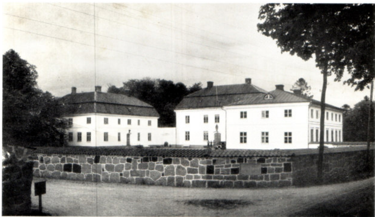
Slottet från stora landsvägen.
